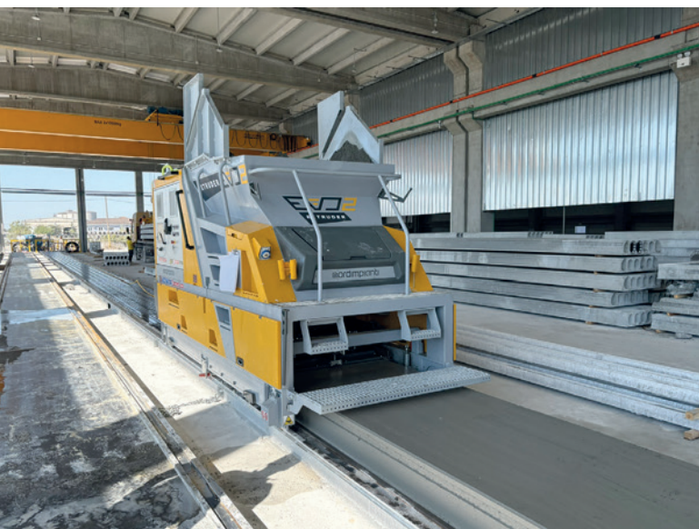
Экструдер EVO2 на стадии укладки бетона
